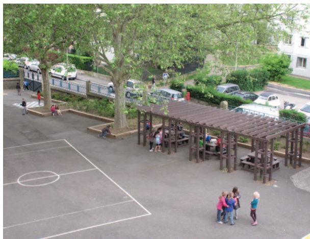
La pergola, nouvellement installée, sera bientôt couverte de plantes grimpantes
