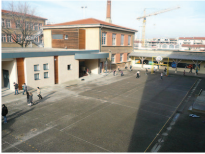
La cour de l'école Jules Verne avant et après les travaux
